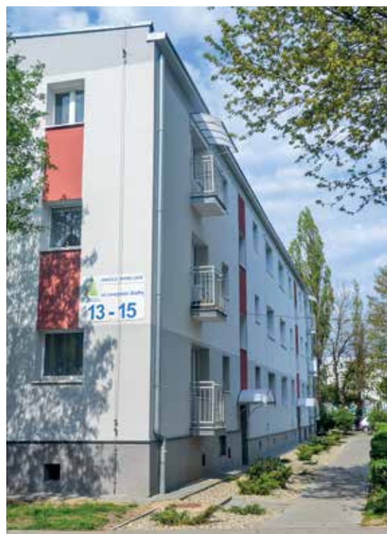
ul. L. Staffa 13-15 - termomodernizacja
