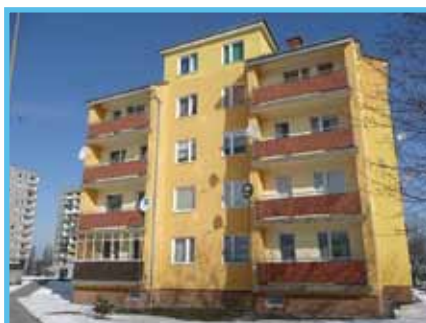
Remont elewacji budynku Lisia 61
