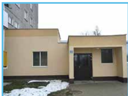
Remont zespołu wejściowego Lisia 55
