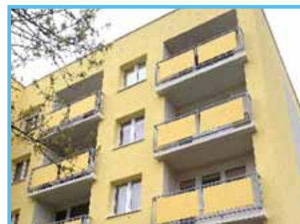
Wymiana balustrad balkonowych II Armii 2 - 14
