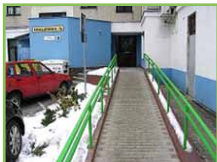
Remont podestów i podjazdów do klatek schodowych Kraljevska 7AB
