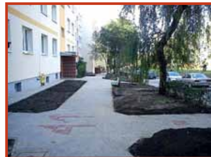
Remont ciągu pieszego przy budynku Zawadzkiego „Zośki” 37-55
