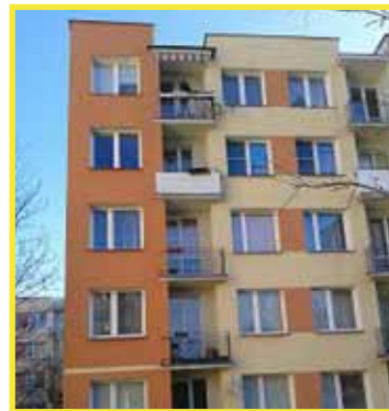
Budynek Armii Krajowej 6
