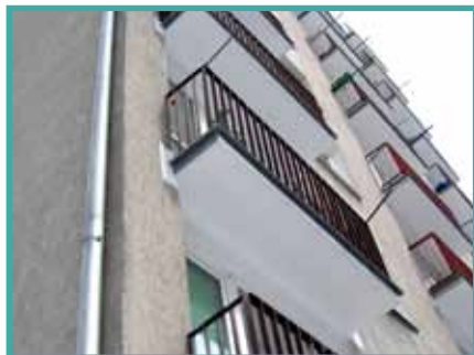
Remont płyt balkonowych Władysława IV 20
